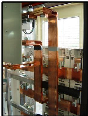
Selbst grosse Ströme von 2000A und mehr können wir handhaben. Grosse Kupferschienen biegen wir mit unserer Maschine passgenau in alle möglichen Winkel.
